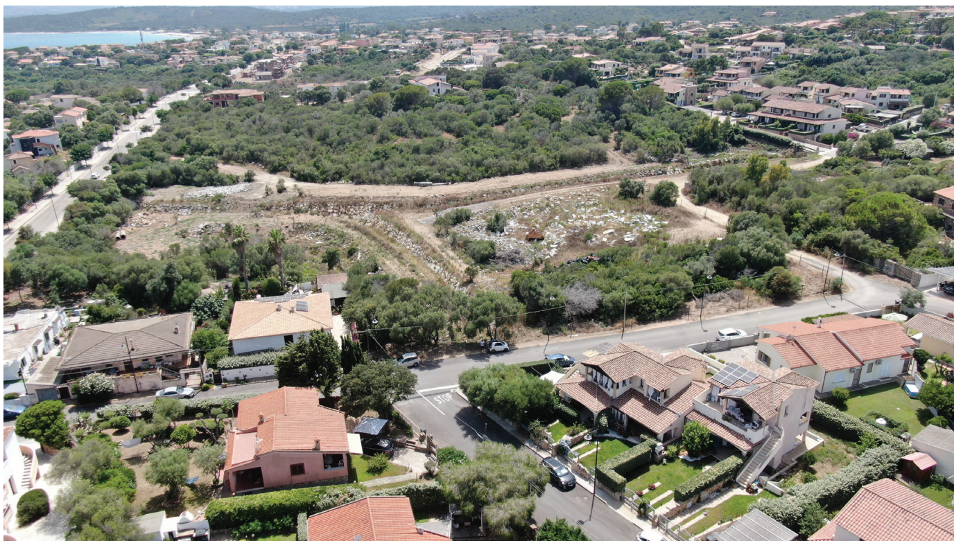
FOTO 1: STATO DI FATTO: Vista aerea Nord-Est
