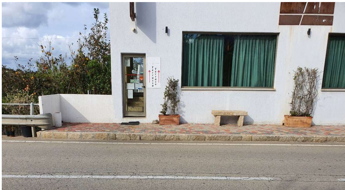
Fig. 6 – Vista del tratto n. 3 – A sinistra il punto di partenza della passerella chiuso dal parapetto in muratura esistente
