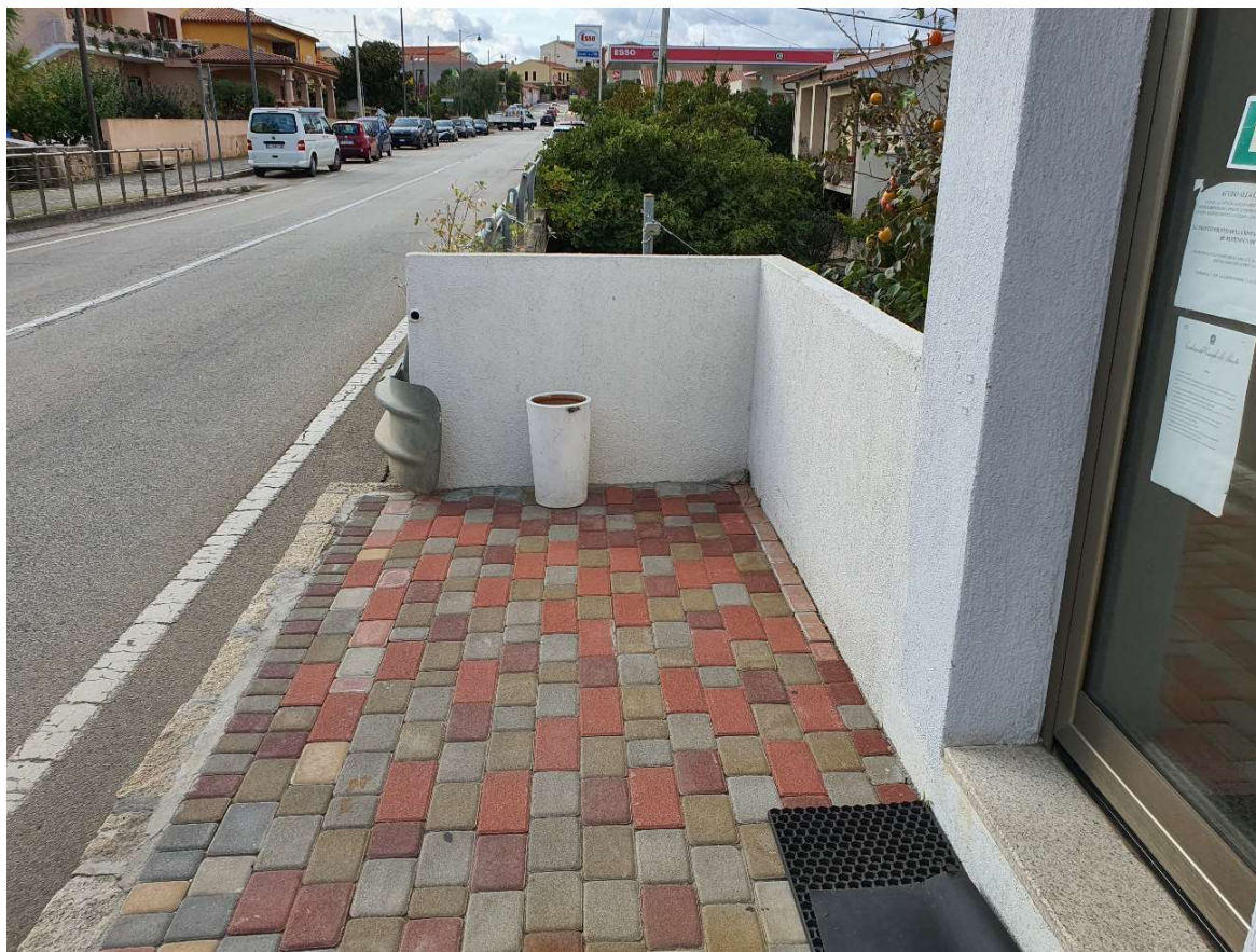
Fig. 4 – Immagine del parapetto che interrompe il tratto 3 in corrispondenza del compluvio
