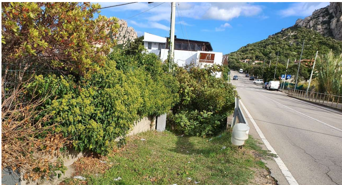
Fig. 8 – A sinistra il muro di recinzione dove dovrà sorgere la spalletta ovest (oggetto di demolizione e ripristino)
