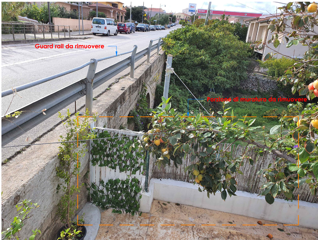
IMMAGINE B Vista delle opere da demolire da est
