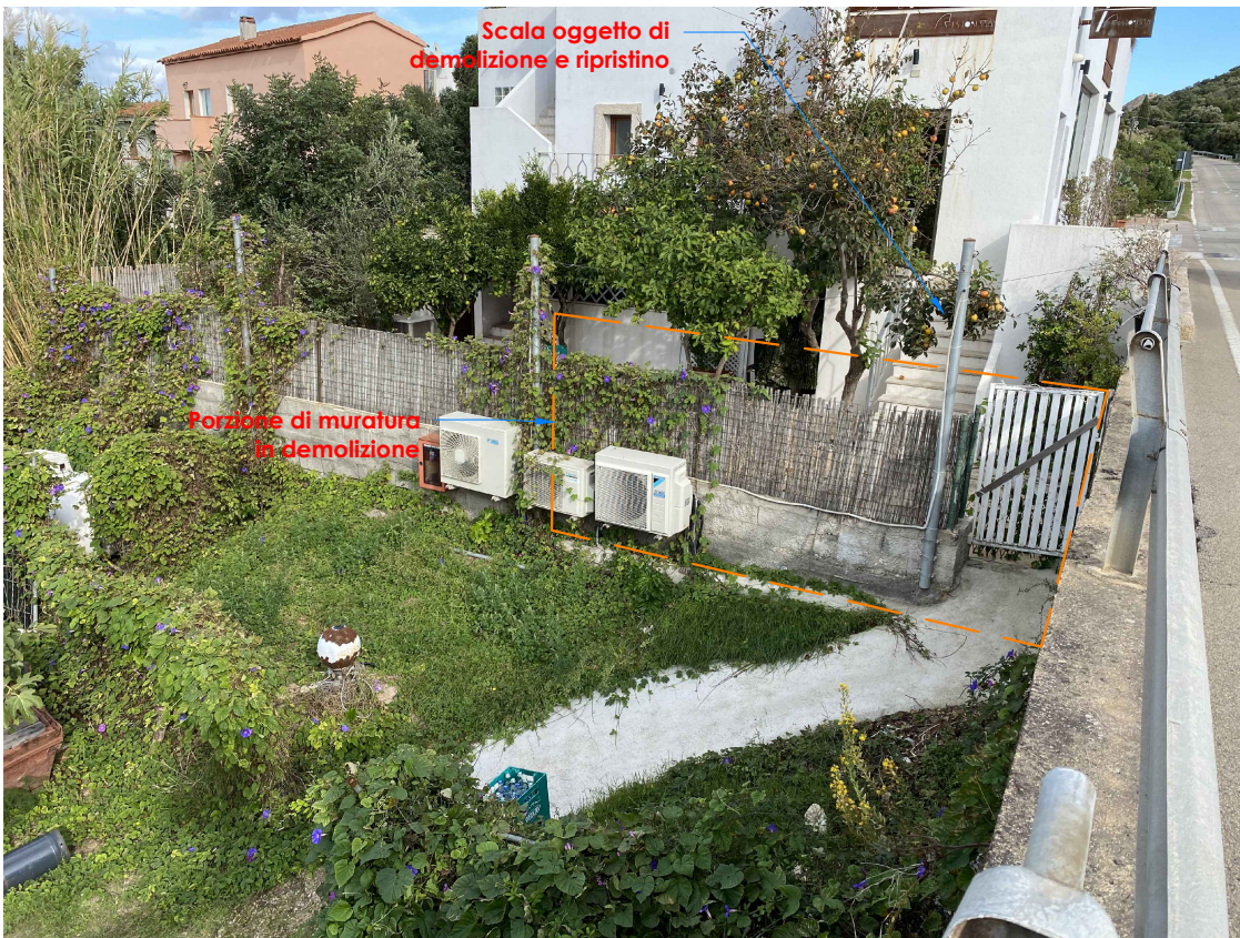
IMMAGINE C Vista delle opere da demolire da ovest
