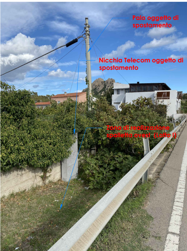
IMMAGINE E Vista dell'area di intervento ovest
